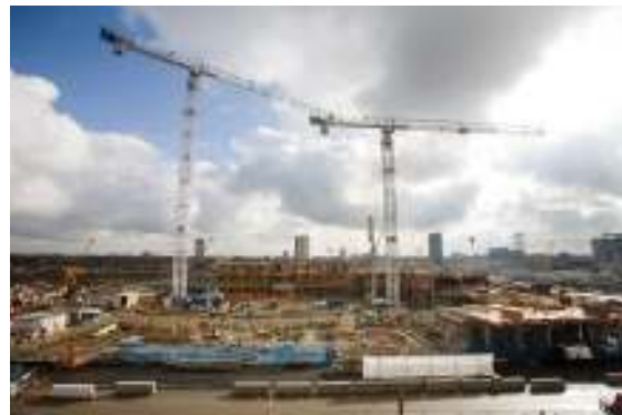
Trên công trường xây dựng làng Olympic 2012
